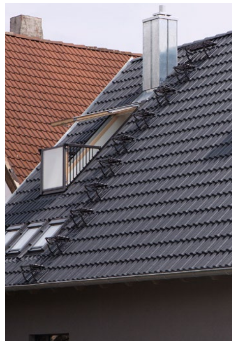
Nosná škridla s držiakom stúpacej plošiny
